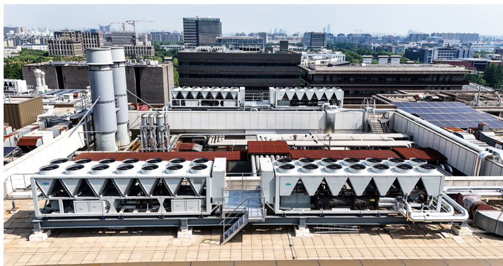
（诺华上海园区三号楼屋顶视角）前景及对面屋顶的成排设备为脱碳项目新增热泵机组
